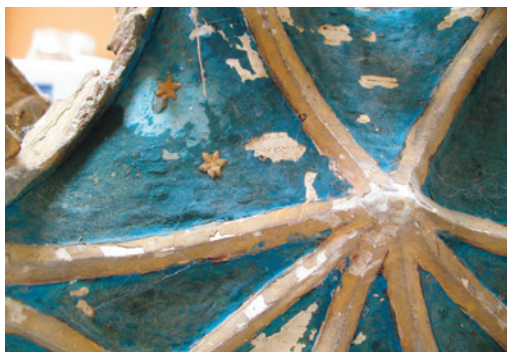
Fig. 23 - Détail de la voûte d'un dais avec les étoiles rapportées
